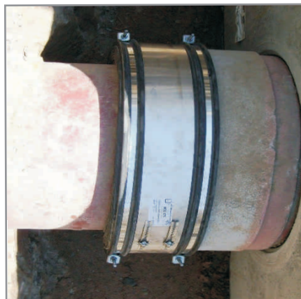
F. Kupplung mittig auf beiden Rohrspitzenden montieren
