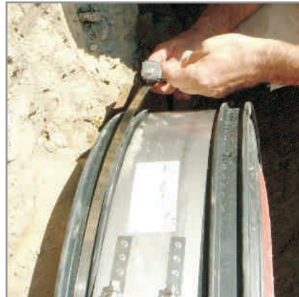
D. Spanneinheiten vormontieren
