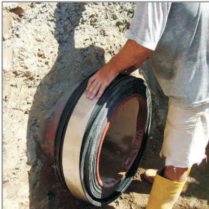
C. Dichtmanschette & Scherband vormontieren
