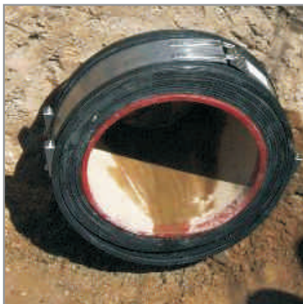
E. Kleinerer AD ist vorbereitet zum Anschluss
