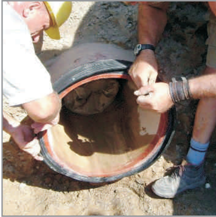
A. Ausgleichsringe aufziehen
