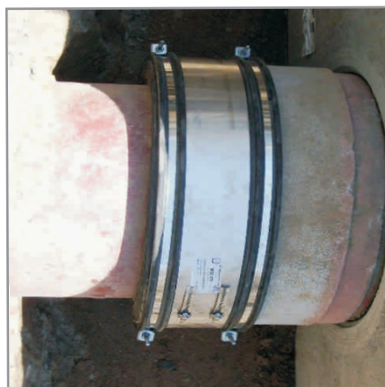
F. Kupplung mittig auf beiden Rohrspitzenden montieren
