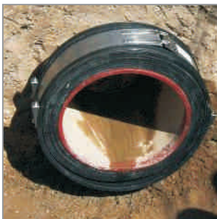
E. Kleinerer AD ist vorbereitet zum Anschluss
