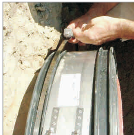
D. Spanneinheiten vormontieren
