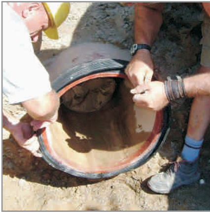
A. Ausgleichsringe aufziehen
