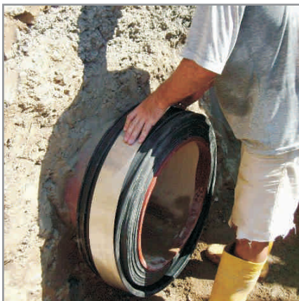
C. Dichtmanschette & Scherband vormontieren
