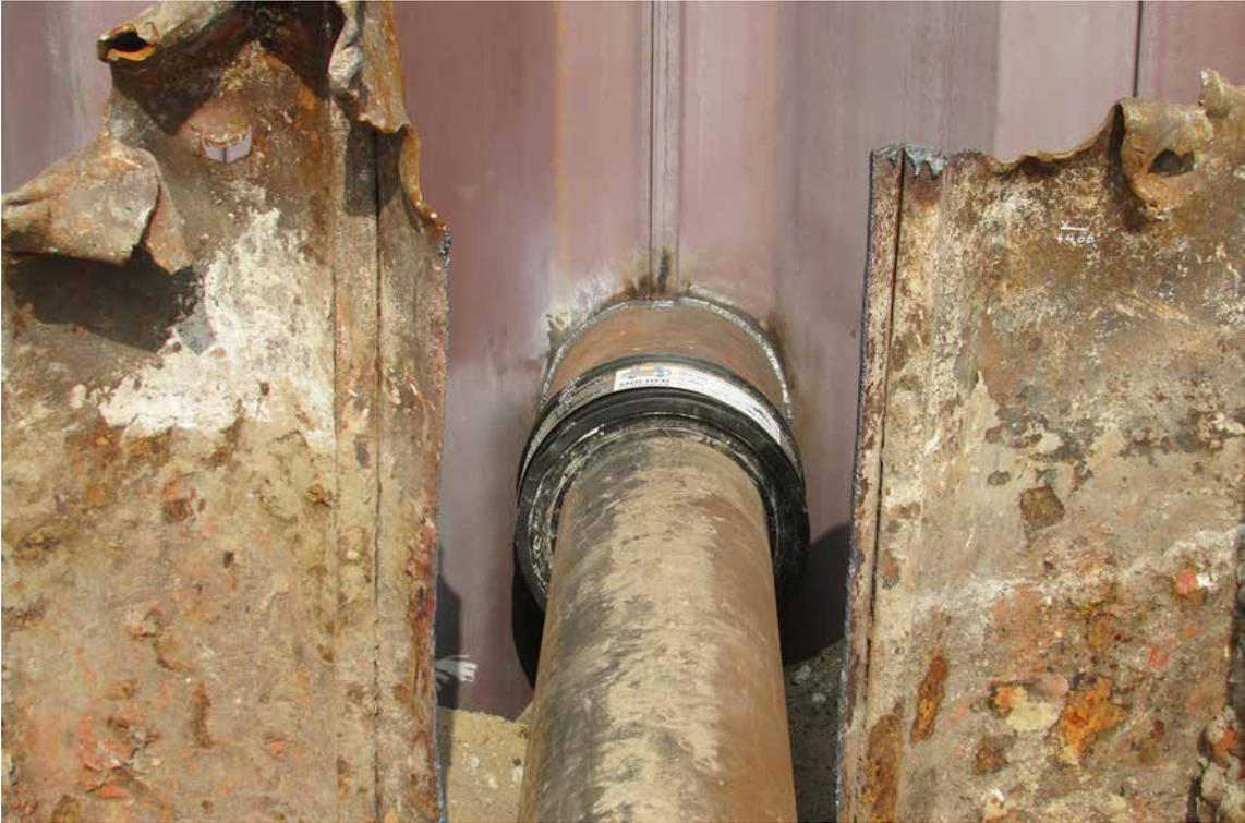
Für die Durchführung der Trinkwasserleitungen wurden kurze Stahlrohre in die Spunddielen eingeschweißt
