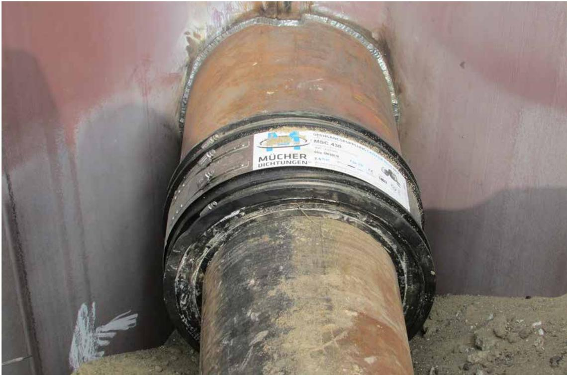
Die Trinkwasserleitungen aus PE sind vor und hinter den Stahlspundwänden mit Stahlrohren geschützt. Die Übergänge bei der Durchführung durch die mit den Spunddielen verschweißten Stahlrohre werden mit Übergangskupplungen Canada Plus 2B flexibel gesichert.
