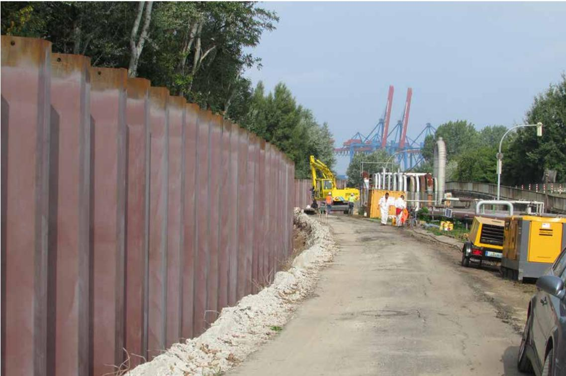
Im Rahmen des Projektes Privater Hochwasserschutz wird die Hochwasserschutzanlage der Poldergemeinschaft Hohe Schaar entlang des südlichen Uferbereichs der Süderelbe unter anderem mit dem Neubau von Spundwänden zum Schutz der Uferbereiche ertüchtigt.
