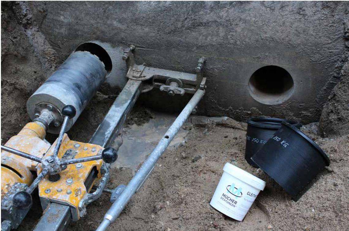
Das Kernbohrgerät wird an dem Mischwasserkanal ausgerichtet und die Bohrung hergestellt.
