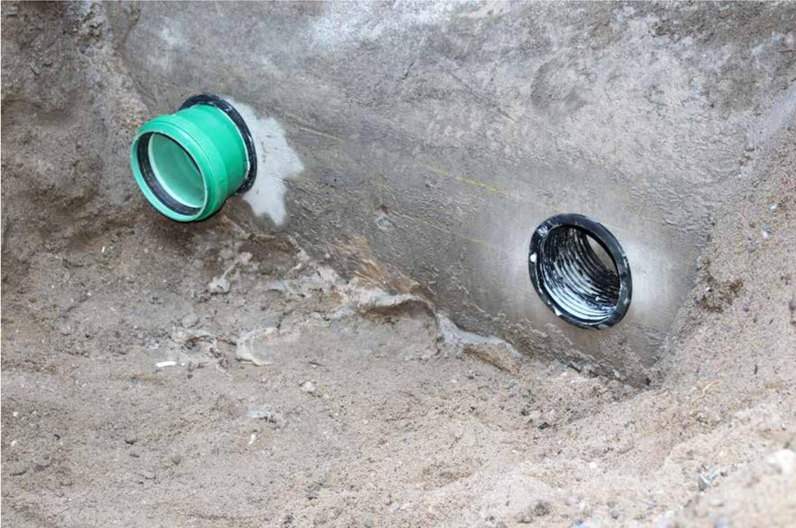
Schnell und dicht: Der linke Anschluss ist soweit fertiggestellt, dass die Anschlussleitung angeschlossen werden kann. Rechts ist die eingebaute und mit Gleitmittel versehene Mücher Ringraumdichtung M140 zu sehen.
