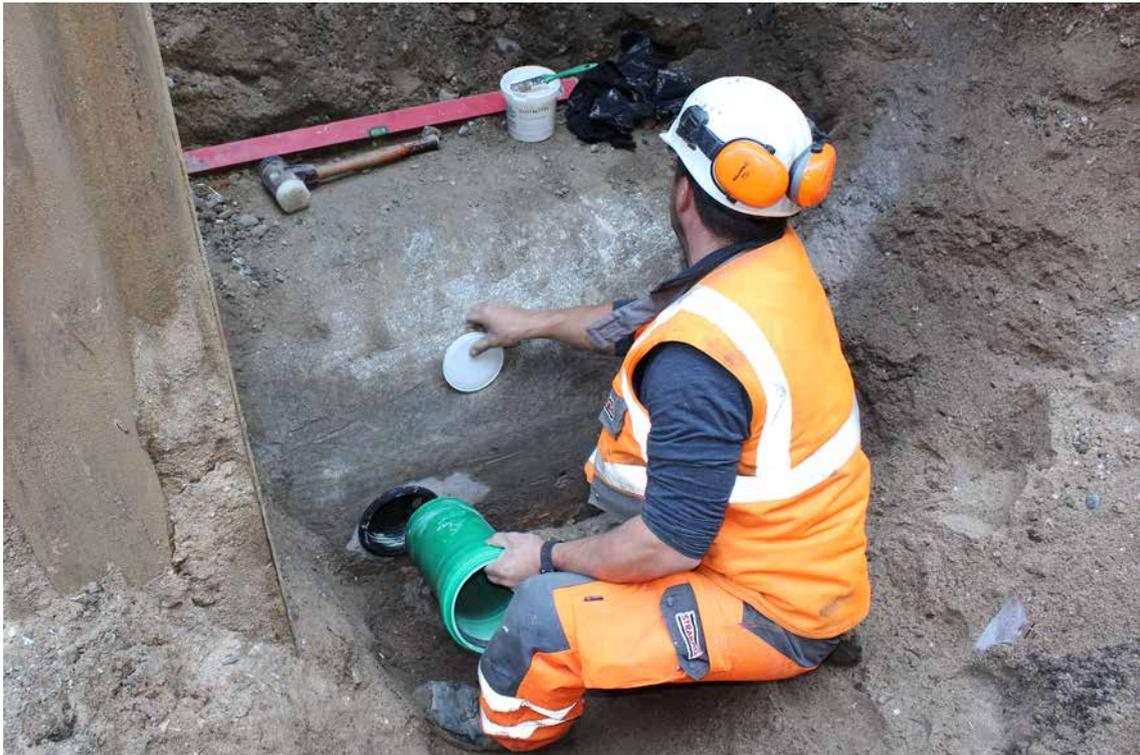
Die Mücher Ringraumichtung M140 ist in die Bohrung eingesetzt. Vor dem Einschieben des Anschlussrohres DN 160 wird das Mücher Gleitmittel auf das Spitzende und die Innenseite der Ringraumichtung aufgetragen.
