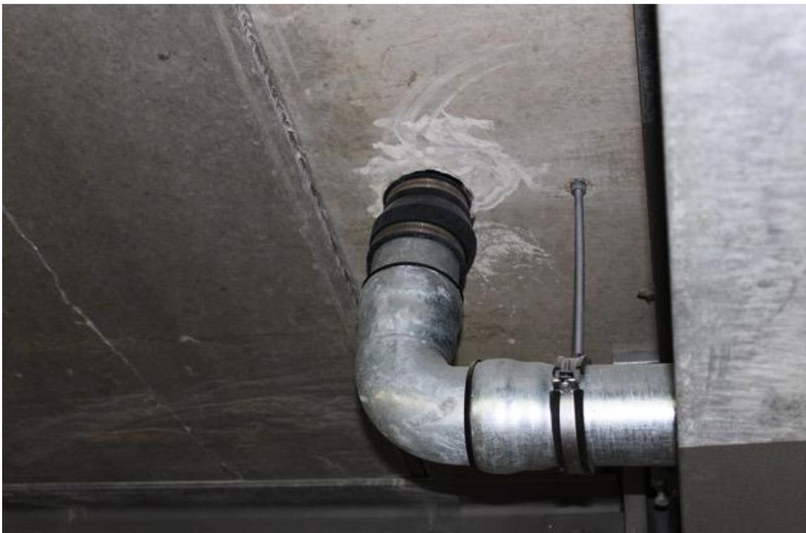
Die MAC-Kupplung verbindet die verzinkten Stahlrohre (ACO-X) DN 100 / DA 102 mit den Ablaufstutzen in den Deckenbereichen.
