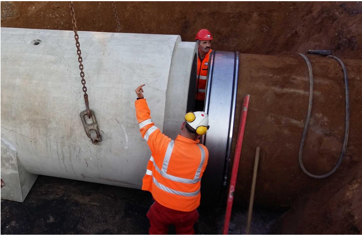
Abb.-6 Anbindung von einem Stahlbetonrohr DN1500 an ein Stahlbetonsonderbauwerk Foto: MÜCHER DICHTUNGEN
