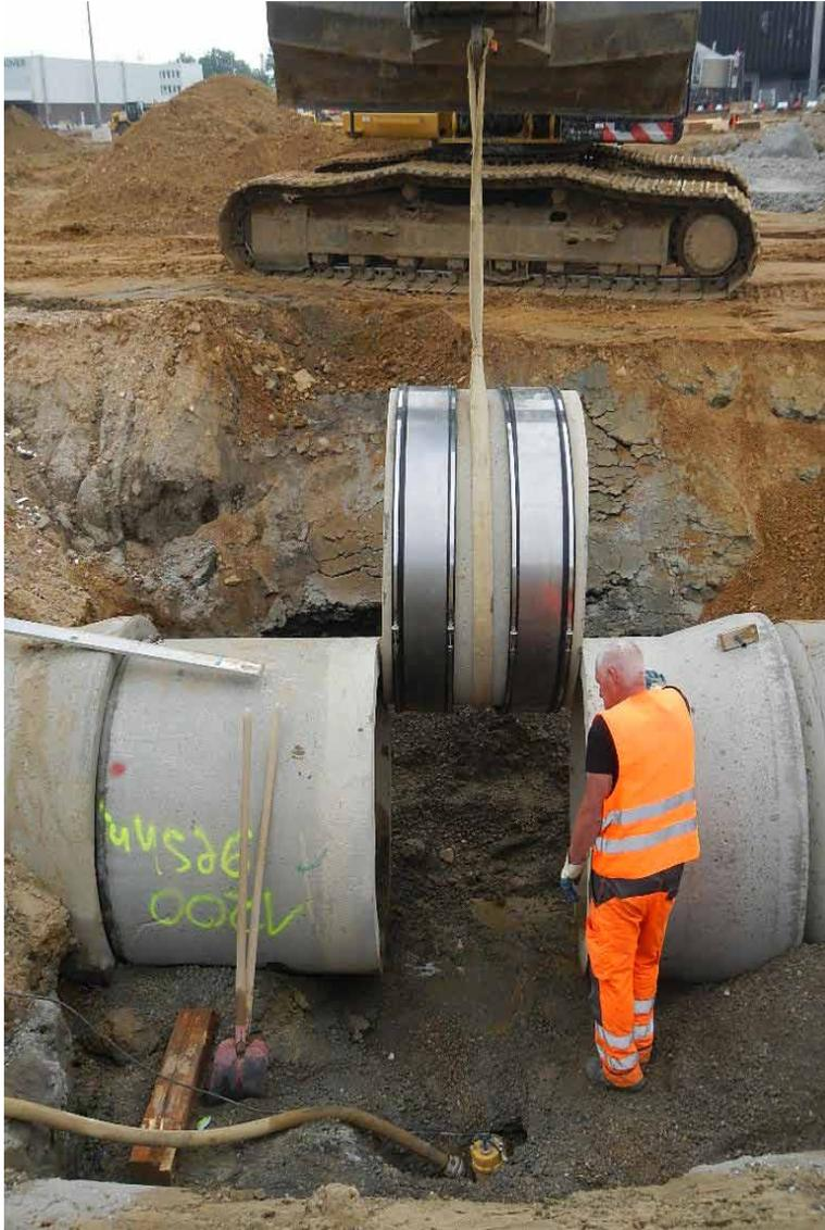
Da sehr viele der eingesetzten Stahlbetonrohre geschnitten werden mussten, kamen Übergangskupplungen von Mücher zum Einsatz.
