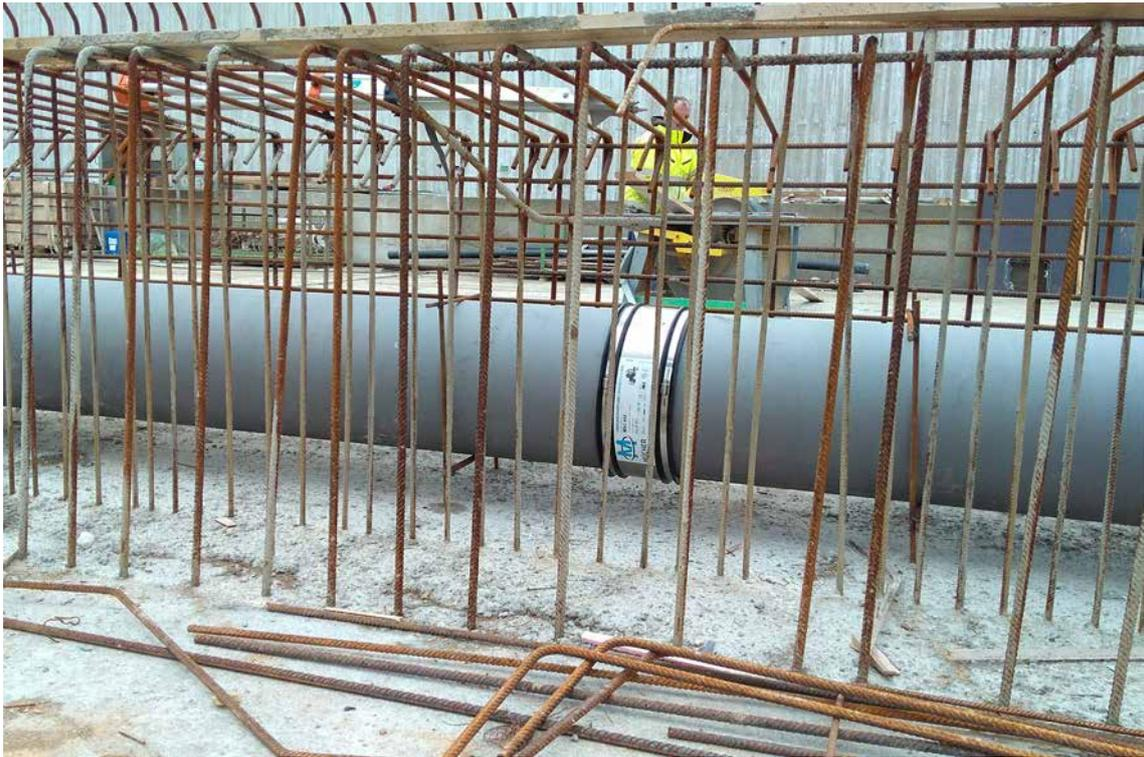
Der MÜCHER BML-Verbinder sorgt für die sichere Verbindung der BML-Rohre.
