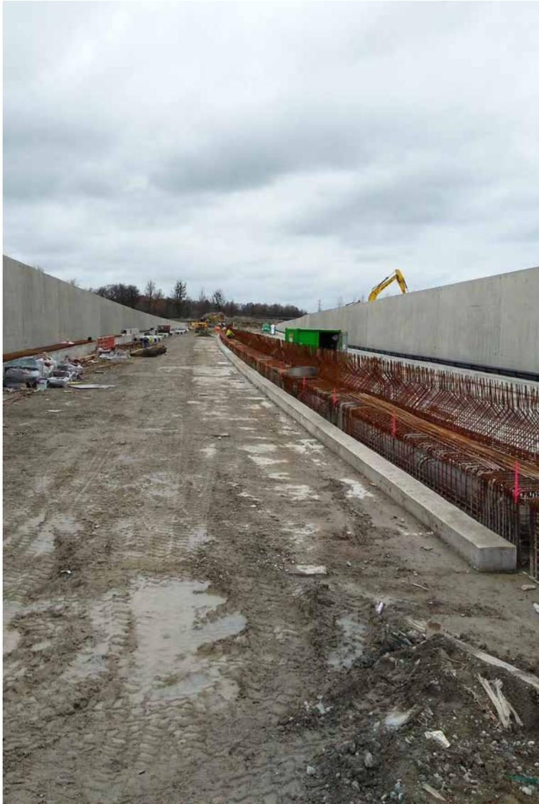
217 BML-Rohre mit 180 MÜCHER BML-Verbinder werden in der rund 600 m langen Grundwasserwanne verlegt.
