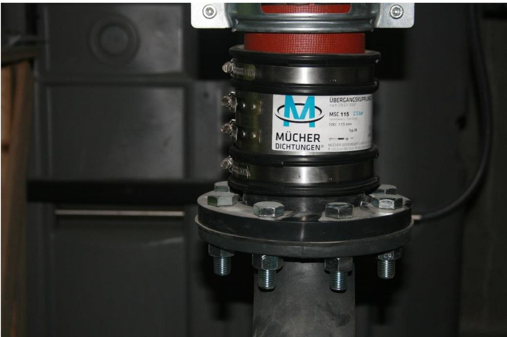
Einbau der Kupplung Canada Plus MSC 115 für eine sichere Verbindung der Hebeanlage.
