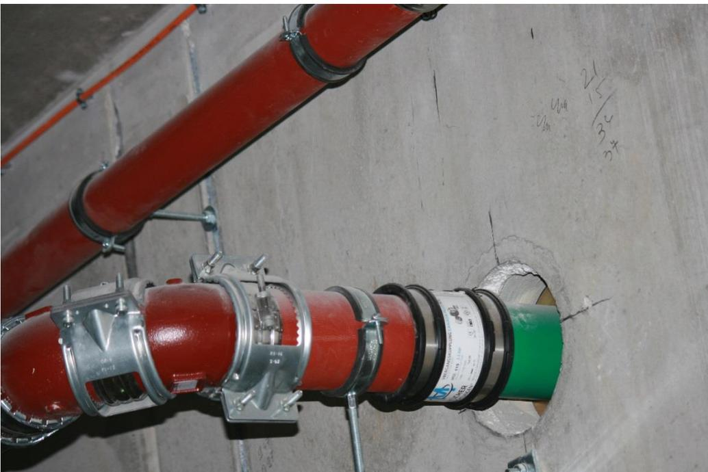
Ein weiterer Anwendungsfall ist die Verbindung von SML-Leitungen DN 100 mit KG 2000 Kunststoffrohren. Hier wurde die Kupplung Canada Plus MSC 115 verwendet.
