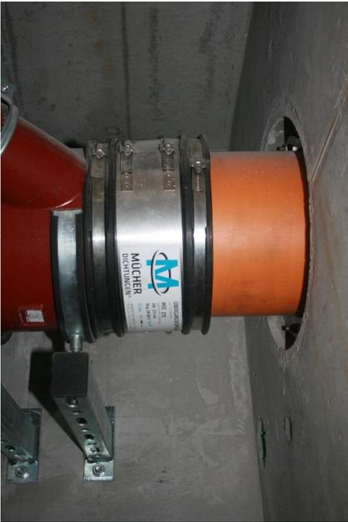
Unterhalb der Erdgeschossesebene sieht man den Übergang der SML-Leitung auf das Kunststoffrohr, zu deren Verbindung die Canada Plus MSC 275 verwendet wurde.
