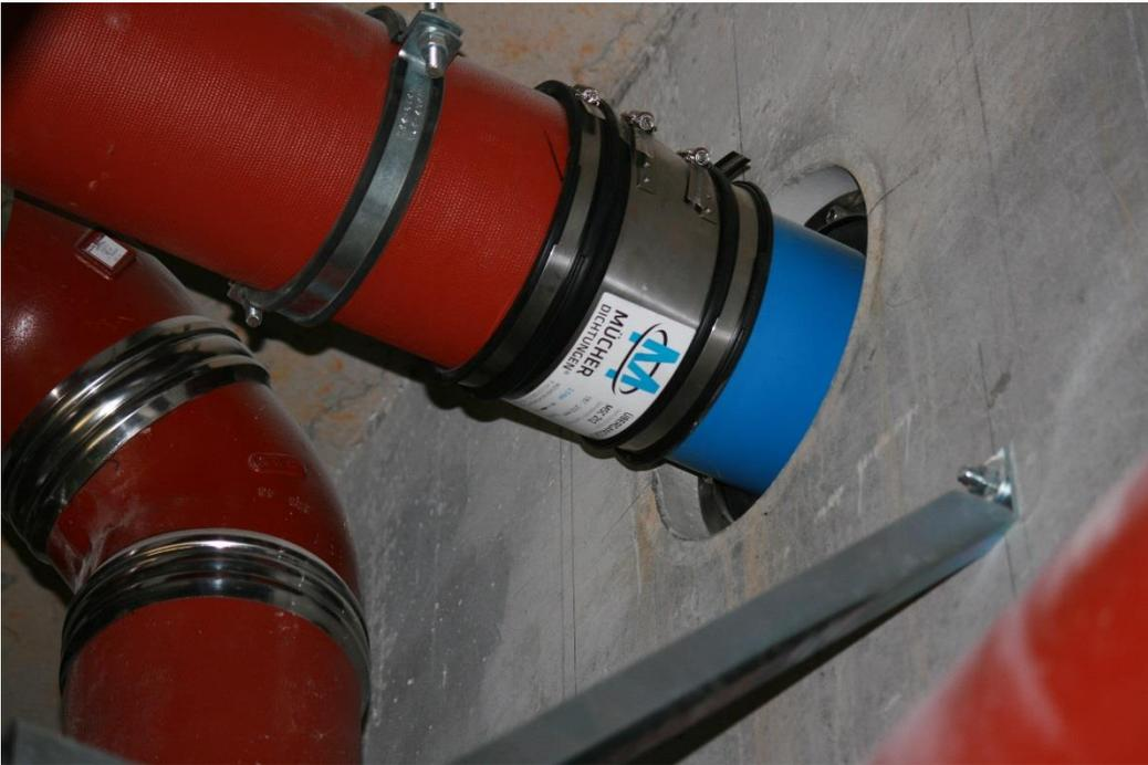
Die Kupplung Canada Plus MSC 212 wurde zur Verbindung einer Regenwasserleitung aus Kunststoff DN 200 mit einer SML-Leitung eingesetzt.
